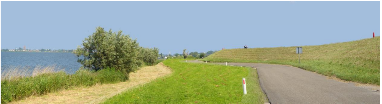
De Uitdammerdijk met een gecombineerde versterking
