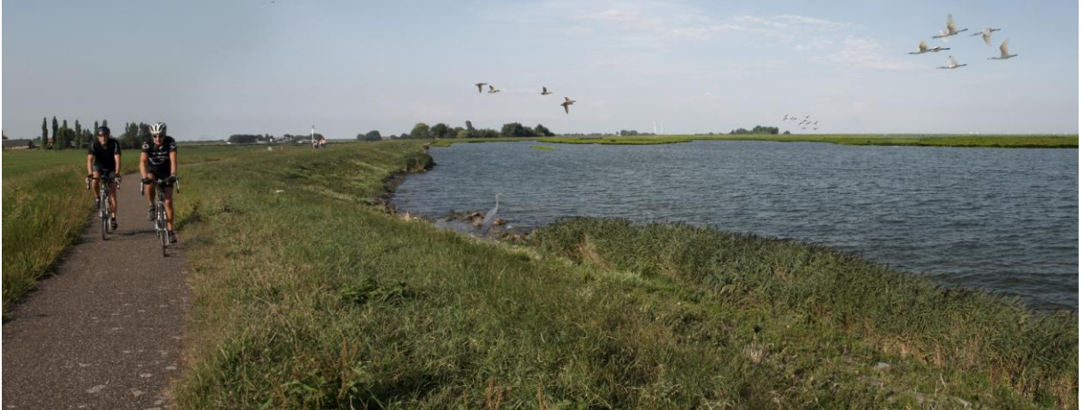
Uitzicht vanaf Kinselmeer/Uitdammerdijk op nieuwe dijk buitenom
