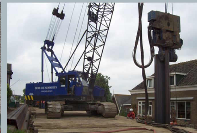
Inbrengen damwand bij bebouwing
