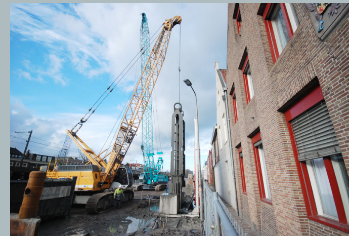
Graven diepwand bij bebouwing
